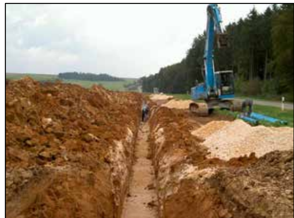
Umlegung einer Trinkwasserleitung im Bereich Eisental, Neenstetten
