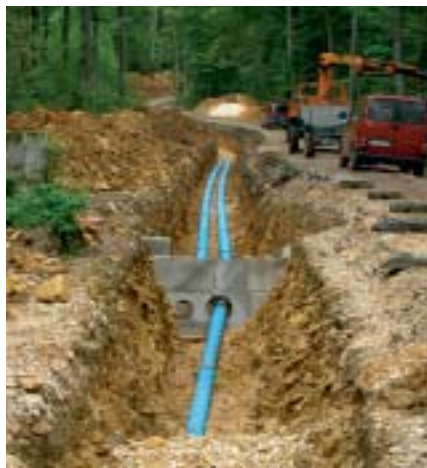
Leitungsneubau und -sanierung
