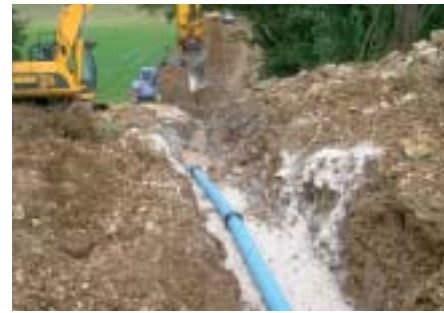
Wasserleitungsbau zwischen Amstetten und Amstetten-Dorf.
