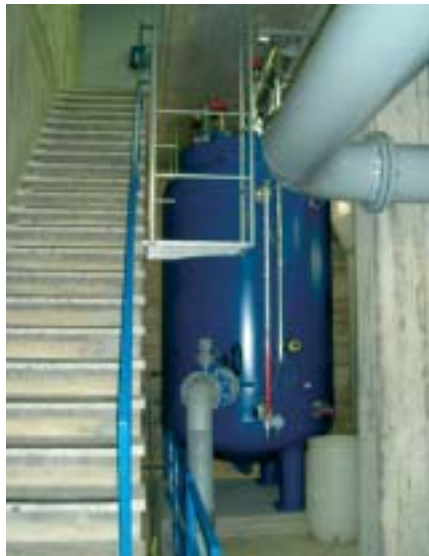
Druckstoßsicherungsanlage LW-Scheitelbehälter.
