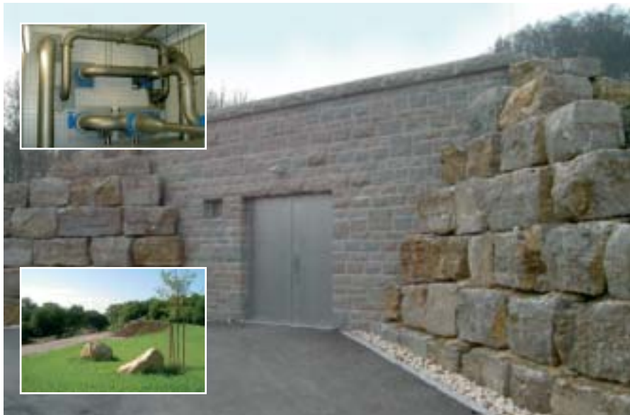
Außen- und Innenansicht (oben) des Reinwasserbehälters Bolheim.
