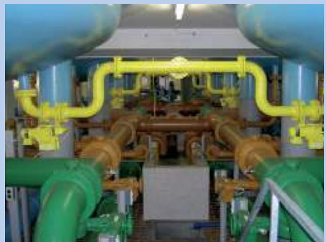
Durch eine Aufbereitungsanlage können im Bedarfsfall Trübungen aus dem Wasser herausgefiltert werden. Neben sechs geschlossenen Sandfilterkesseln ist eine Ozonanlage im Einsatz, die auch organische Verunreinigungen umweltschonend beseitigt und gleichzeitig das Wasser desinfiziert. Zusätzlich kann noch eine Transportdesinfektion eingesetzt werden.
